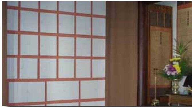
ほんどうのうこつどう かいしゅう ようす しゃしんじょうげ しゃしんうえ うつ 本堂納骨堂の改修の様子 (写真上下) 写真上に写っているのは別院職員の山崎パウロさん。
